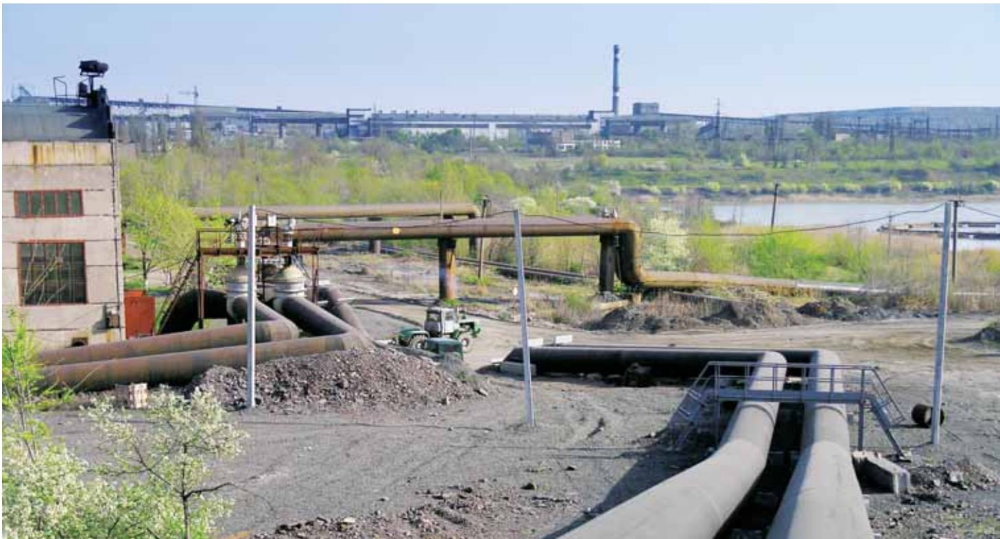
Строительство самотечных водоводов для подачи технической воды на обогатительную фабрику ОАО «ИнГЭК»
